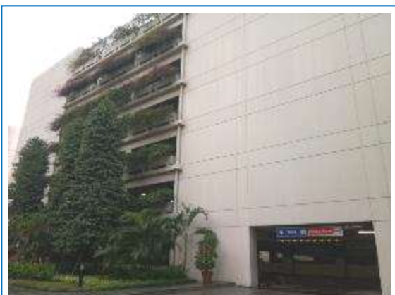
Gedung Parkir Sentral Senayan III
