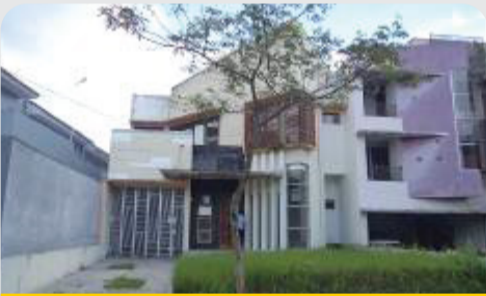
Rumah Tinggal, Perumahan Andalusia Garden Kav. Villa No. 3, Kelurahan Kahuripan, Kecamatan Tawang, Kecamatan Tasikmalaya, Jawa Barat
